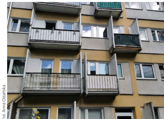
Rys. 2. Os. J. Słowackiego, fragment elewacji budynku, Lublin 2022 r.
