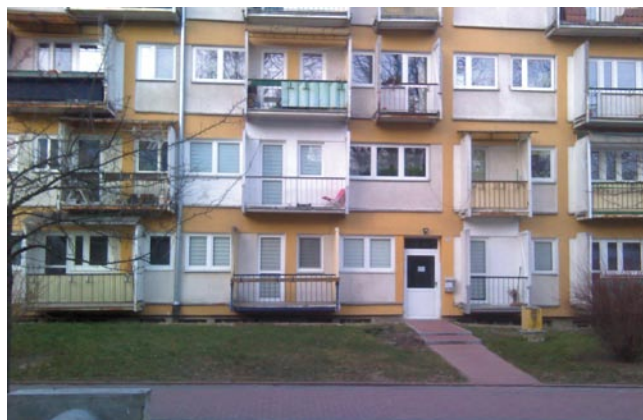
Rys. 6. Fragment elewacji budynku wielorodzinnego; po ociepleniu I etapu, Lublin 2023 r.
