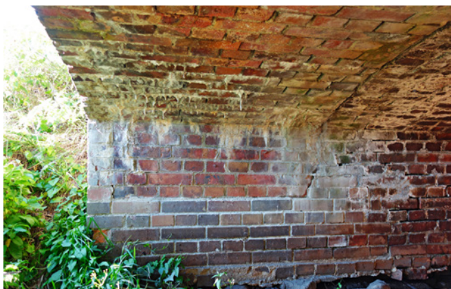
Ryc. 4. Przykłady wykwitów i nacieków na powierzchni konstrukcji przepustów ceglanych, fot. A. Wysokowski
