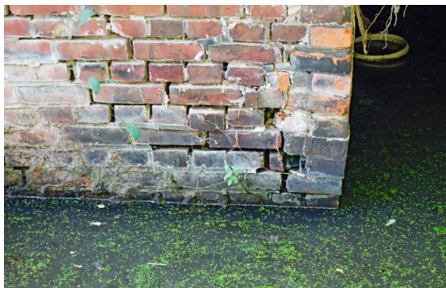
Ryc. 5. Przykłady uszkodzeń ceglanych elementów konstrukcyjnych przepustów w postaci deformacji, przemieszczeń i spękań, fot. A. Wysokowski
