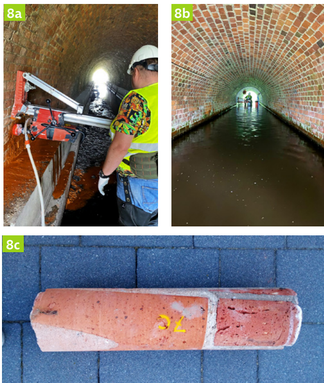
Ryc. 8a, 8b, 8c. Widok badań wytrzymałościowych (etap pobrania próbek rdzeniowych przez współautora artykułu) oraz przykładowa próbka konstrukcji ceglanej, fot. archiwum firmy Infrastruktura komunikacyjna Sp. z o.o., Żmigród
