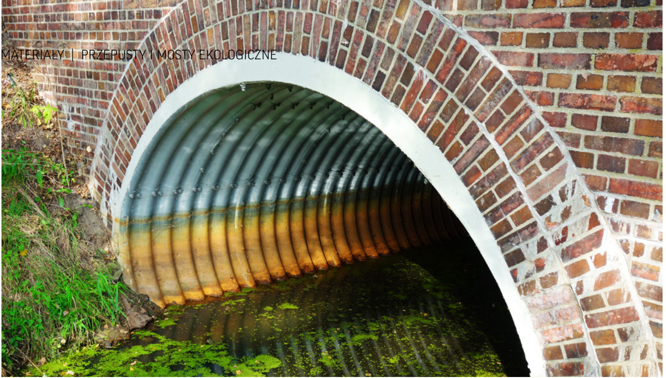
Ryc. 9. Widok przykładowego obiektu ceglanoego po renowacji z wykorzystaniem technologii reliningu z użyciem stalowych blach falistych, fot. A. Wysokowski
