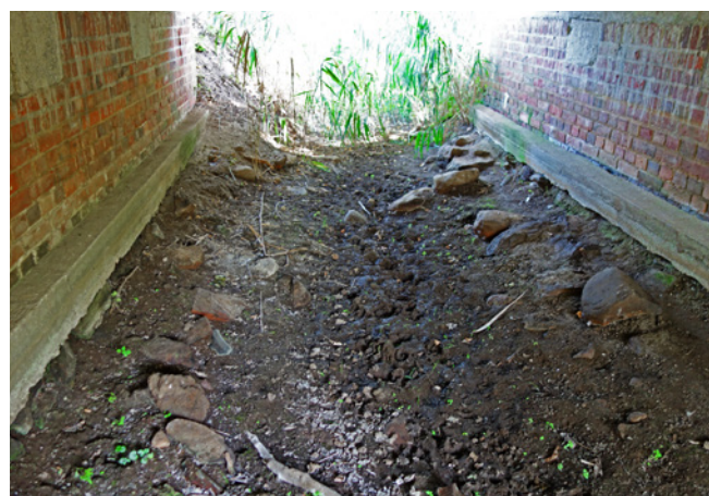
Ryc. 1. Przykład przepustu o konstrukcji mieszanej, ceglano-betonowej, który wykorzystywany jest jako dolne przejście dla zwierząt (widoczne tropy zwierząt kopytnych i drapieżników), fot. A. Wysokowski
