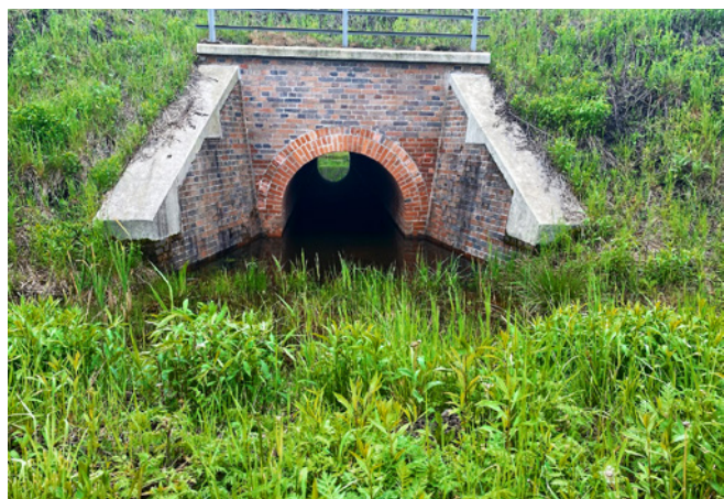
Ryc. 2. Przykład kolejowego przepustu ceglanego z początku XX w. o konstrukcji w postaci sklepienia półkolistego, zachowanego w dobrym stanie technicznym, fot. J. Howis
