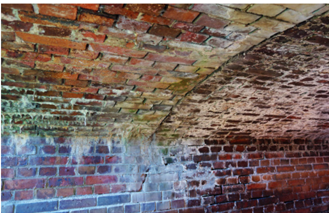
Ryc. 6. Przykłady uszkodzeń przepustów ceglanych w postaci regularnych spękań, fot. A. Wysokowski
