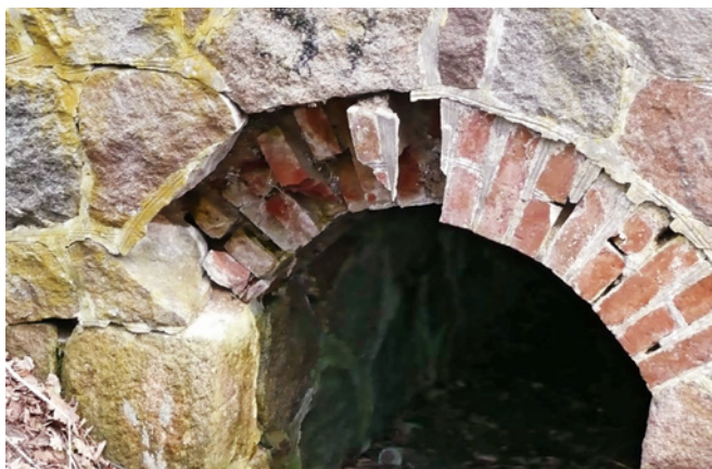
Ryc. 3. Przykłady uszkodzeń przepustów w postaci ubytków spoin i cegieł, fot. A. Wysokowski
