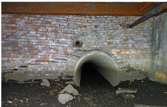
Ryc. 5. Przykłady uszkodzeń ceglanych elementów konstrukcyjnych przepustów w postaci deformacji, przemieszczeń i spękań, fot. A. Wysokowski
