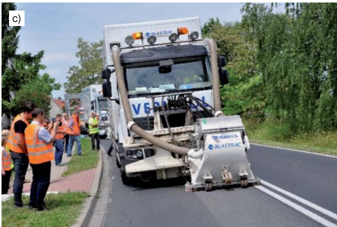
Fot. 7. Wykonywanie remontu w technologii śrutowanie – młotkowanie: a) zestaw do wykonywania śrutowania, b) głowica robocza, c) pokaz podczas wykonywania remontu, d) wykonywanie remontu na łuku (fot. A. Polecki)
