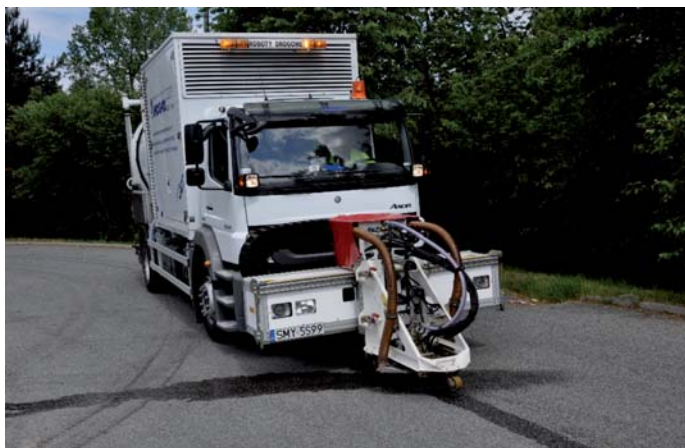
Fot. 4. Czyszczenie wysokociśnieniowe wodą (fot. A. Polecki)
