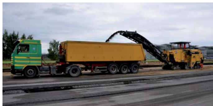
Fot. 1. Frezowanie, całkowita wymiana warstwy ścieralnej [2]
