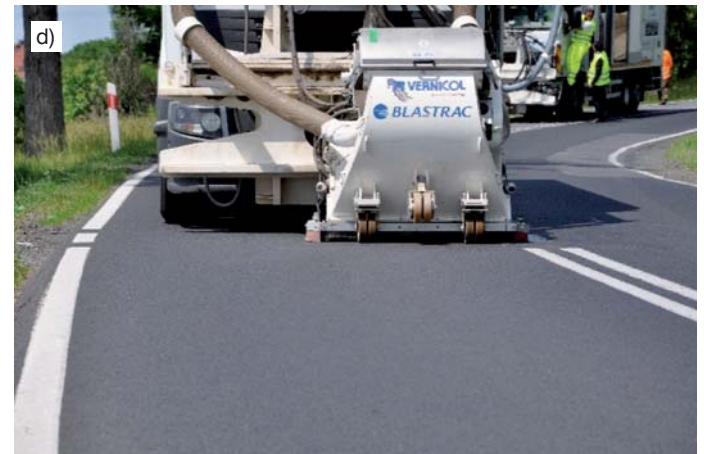
Fot. 7. Wykonywanie remontu w technologii śrutowanie – młotkowanie: a) zestaw do wykonywania śrutowania, b) głowica robocza, c) pokaz podczas wykonywania remontu, d) wykonywanie remontu na łuku (fot. A. Polecki)
