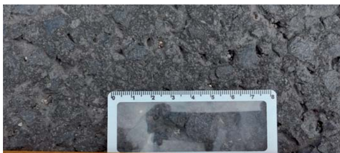
Fot. 11. Widok warstwy ścieralnej po jednym roku eksploatacji (fot. A. Polecki)
