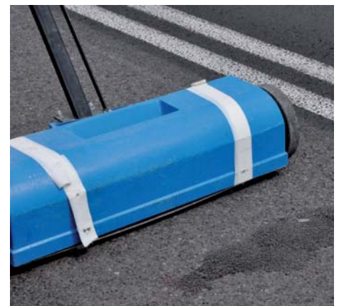
Fot. 8. Zbieranie z nawierzchni pozostałego nadmiaru kulek stalowych (fot. A. Polecki)
