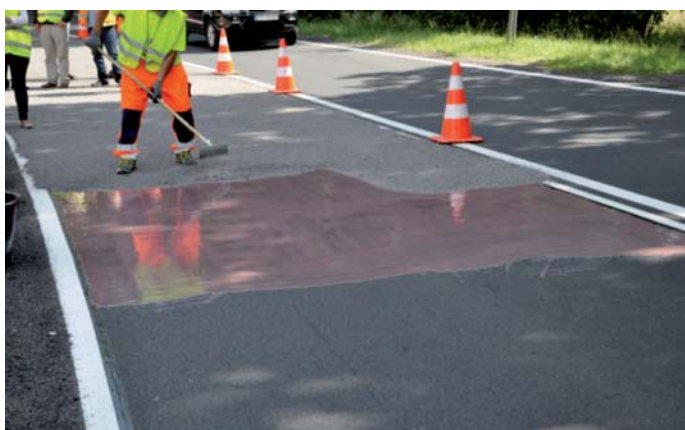
Fot. 5. Nakładka z kruszywa boksytowego (fot. A. Polecki)
