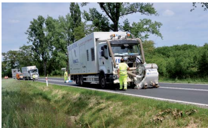
Fot. 6. Śrutowanie – młotkowanie (fot. A. Polecki)
