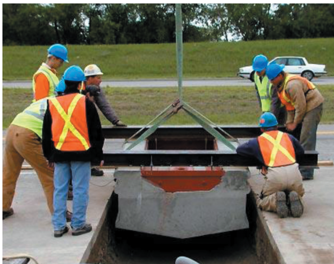
Fot. 1. Montaż wagi tensometrycznej
