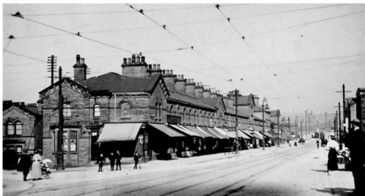
Ryc. F. Osiedle robotnicze Saltaire nieopodal Bradford. Projekt zagospodarowania (u góry) oraz pasaż handlowy Gordon Terrace (u dołu). Źródło: [F].
