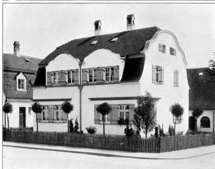
Ryc. J. Kolonia robotnicza Gmindersdorf nieopodal Reutlingen (Badenia-Wirtembergia) – u góry oraz przykład zabudowy cztero-rodzinnej – u dołu. Źródło: [J].
