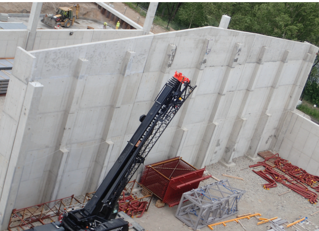
Rys. 3. Wygląd zrealizowanej ściany
