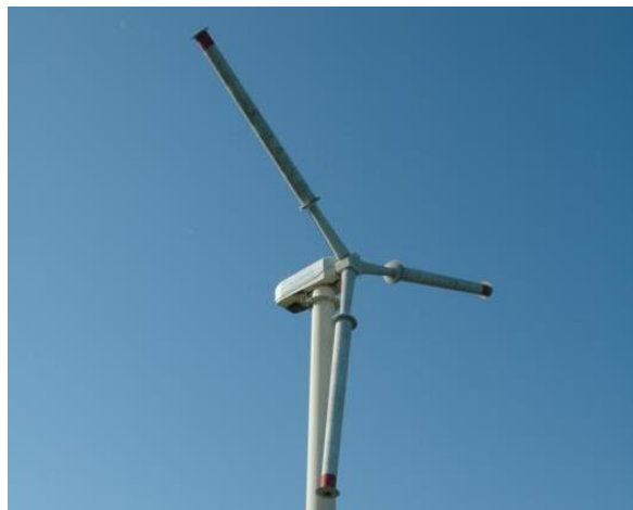
Rys. 7. Turbina wykorzystująca efekt Magnusa zainstalowana w Pagórkach [18]
