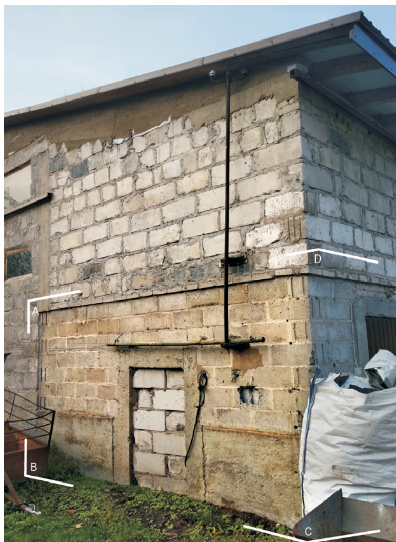
Ryc. 4. Budynek inwentarski z pustaków żużlobetonowych w Piętkach-Gręzkach (ABCD – zachowane żużlobetonowe ściany); fot. E. Milewska
