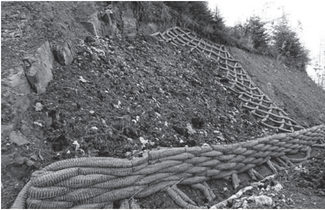
Rys. 6. Widok skarpy przysypanej kompozytem gruntu z wyczesami wełnianymi
