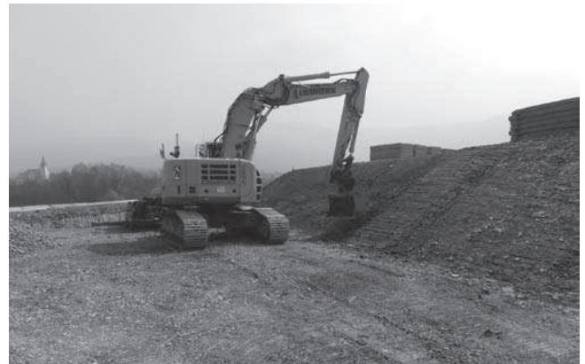
Rys. 2. Zagęszczanie gruntu z włóknami na skarpie łyżką koparki
