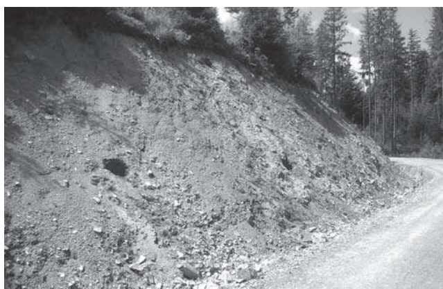
Rys. 5. Widok ogólny stanowiska badawczego
