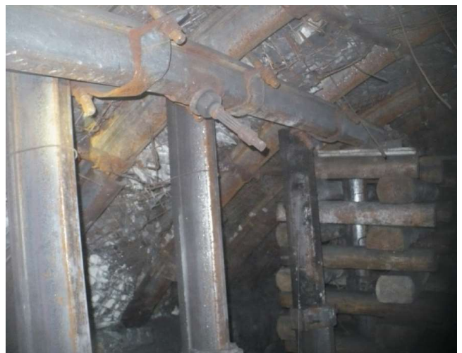
Rys. 8. Zdjęcie chodnika PW-1 za skrzyżowaniem ze ścianą – odcinek badawczy I z wykorzystaniem kotew strunowych
