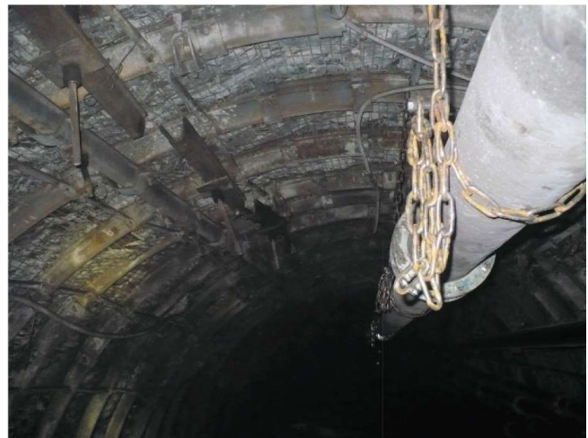
Rys. 7. Ogólny widok chodnika PW-1 przed ścianą – odcinek badawczy II, widoczny zniszczony strop
