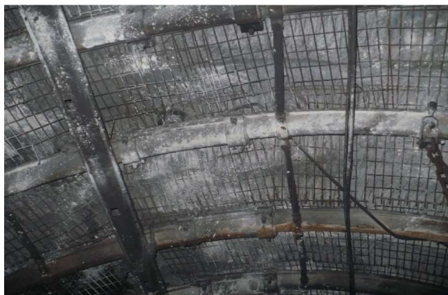
Rys. 9. Zdjęcie chodnika 25a – odcinek badawczy II – obudowa podporowa z podciąganiem stalowym niekotwionym Fig. 9. The general view of maingate 25a – testing section II – standing support with hoisting joist
