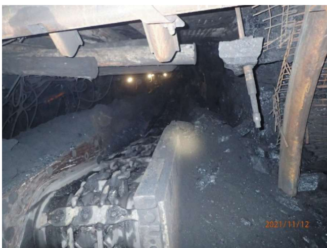
Rys. 11. Widok skrzyżowania ściana-chodnik, niewykruszony ocios przy wypiętych czterech łukach ociosowych – odcinek badawczy II Fig. 11. The cross-cut with maingate 9b – testing section II – the intact rock in the sidewall despite dismantled four side arches
