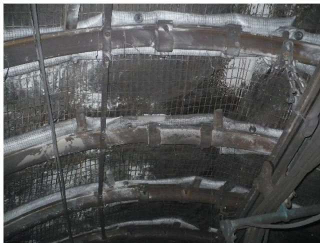
Rys. 12. Zdjęcie chodnika 9b – odcinek badawczy II z wykładką mechaniczną, idealny stan stropu Fig. 12. The general view of maingate 9b – testing section II with bullflex bags, perfect state of the roof
