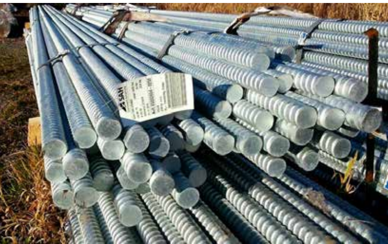
Ryc. 1. Pręty SAS na placu budowy
