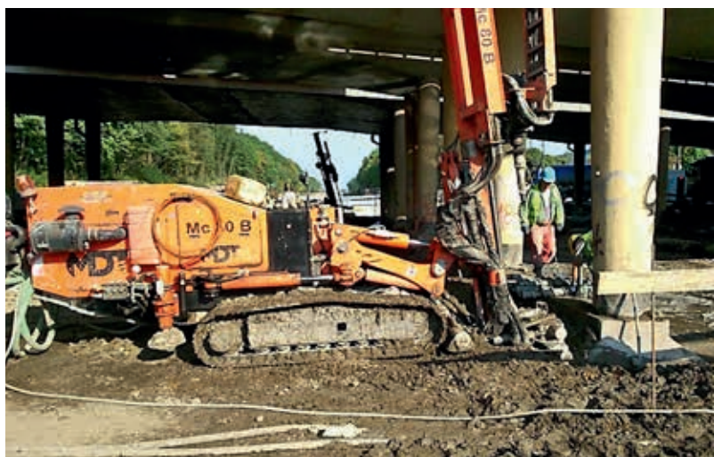
Ryc. 3. Wzmacnianie fundamentów istniejącego wiaduktu za pomocą mikropali SAS 670/800 o średnicy pręta 43 mm
