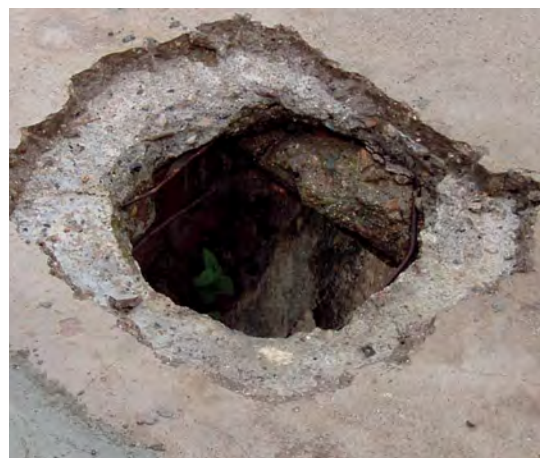
Rys. 3. Odkrytka posadзки – podkład cementowy na żelbetowym stropie
