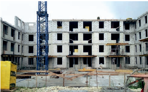
Rys. 1. Widok ogólny budynku. Fig. 1. General view of the building.
