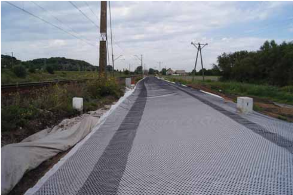
Fot. 1. Rozłożony georuszt trójosiowy na geowłókninie
