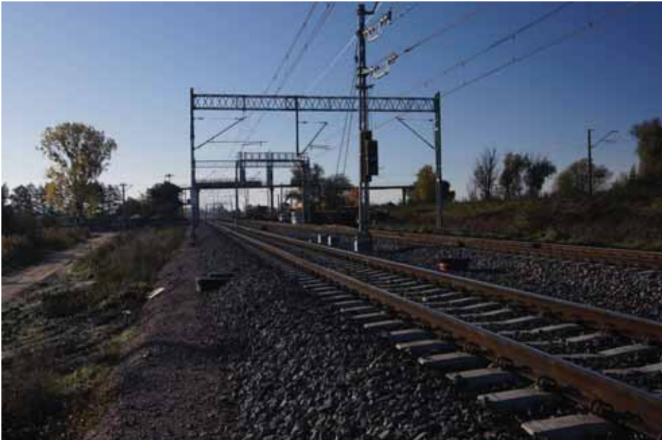
Fot. 3. Wykonana nawierzchnia kolejowa
