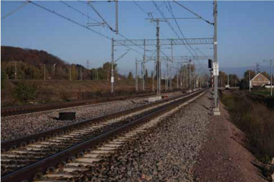
Fot. 4. Wykonana nawierzchnia kolejowa
