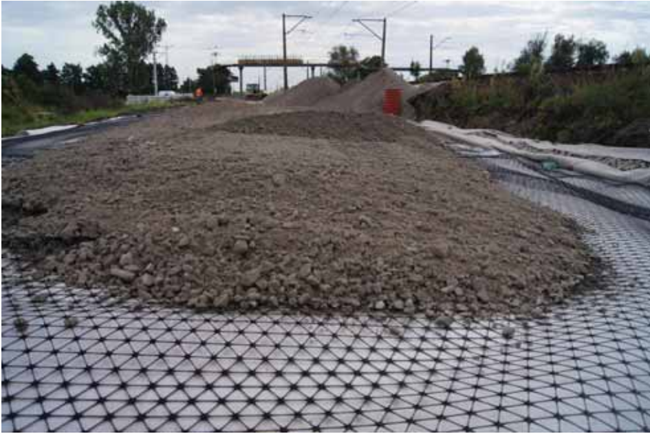
Fot. 2. Układanie kruszywa na warstwie georusztu trójosiowego
