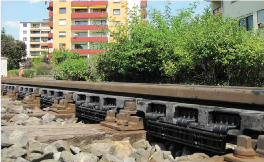
Rys. 6. Przykład zastosowania dynamicznego tłumika przyszynowego z dodaną masą - według [10]
