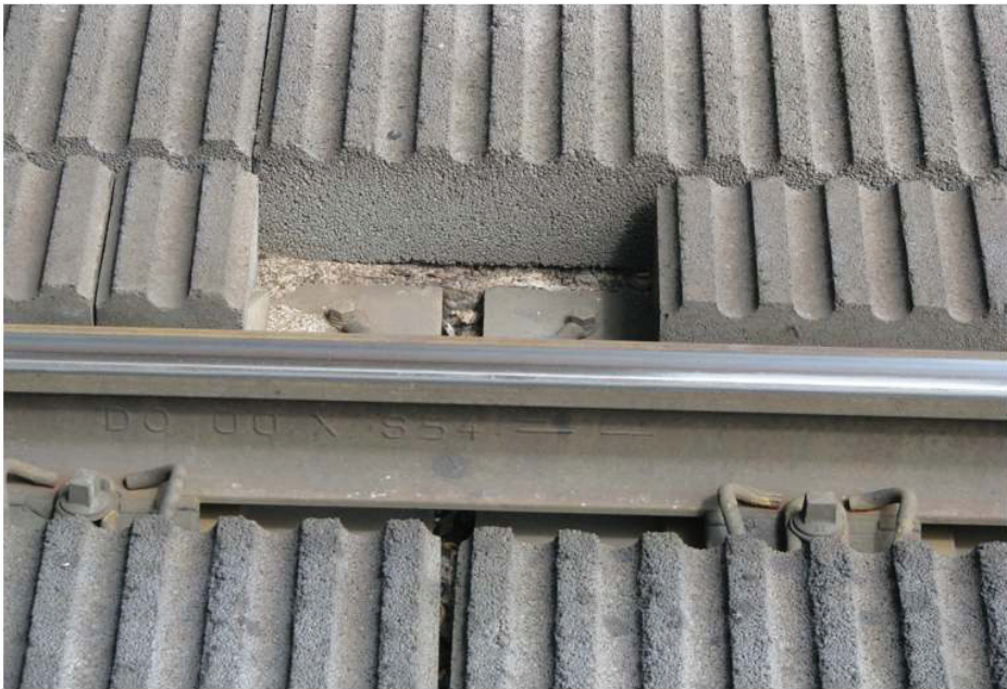
Rys. 9. Widok szczegółu konstrukcji tłumików torowych z betonu porowatego, stosowanych na kolejach niemieckich DB Foto – W. Oleksiewicz
