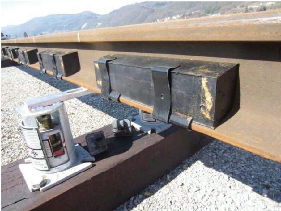
Rys. 5. Przykład zastosowania dynamicznego tłumika przyszynowego z dodaną masą tłumiącą. – według [10] i [7]
