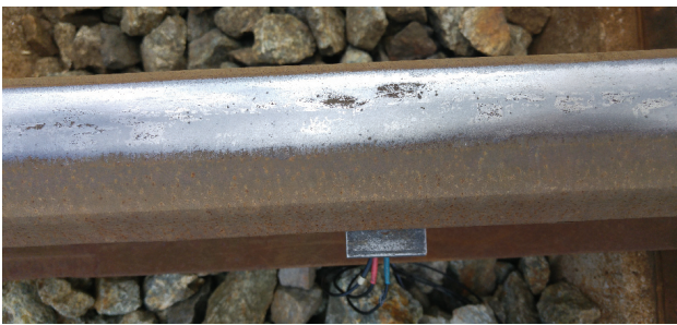
Rys. 2. Wada wybuxsowanie na linii kolejowej nr 213 Reda – Hel [fot. autorów]
