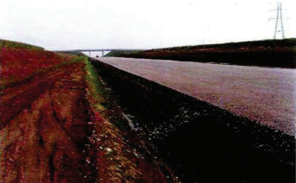
Rysunek 4. Podłoże stabilizowane wapnem, pokryta warstwą ochronną - linia LGV Nord
