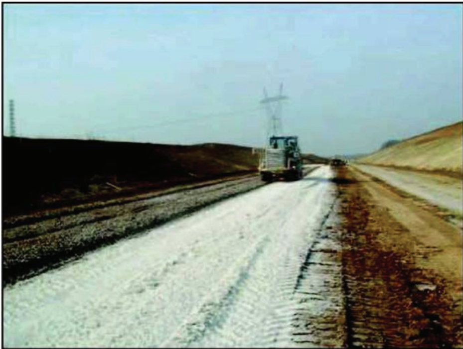
Rysunek 5. Stabilizacja podłoża wapnem - linia LGV Rhin Rhône
