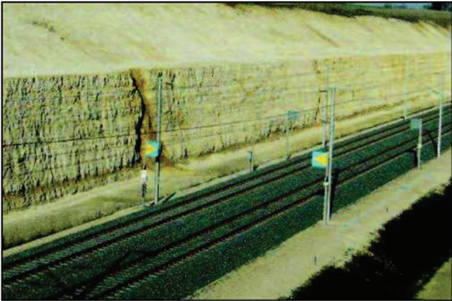
Rysunek 3. Przekop z zabezpieczeniami przed spadającymi kamieniami -LGV Rhin Rhône
