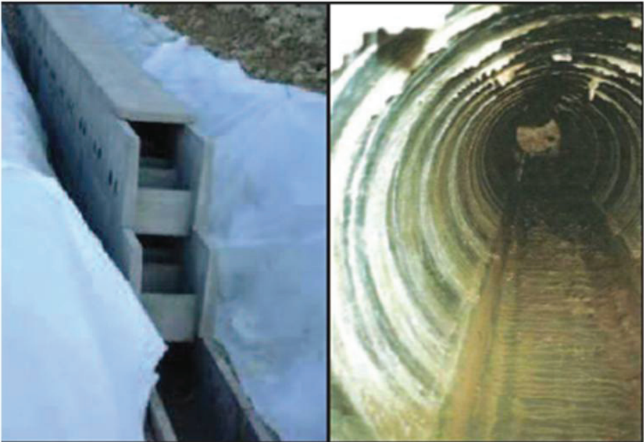
Rysunek 7. Przygotowana fosa z otworami drenażowymi; złożone szpatu wapiennego w kolektorze odpływowym - LGV Nord
