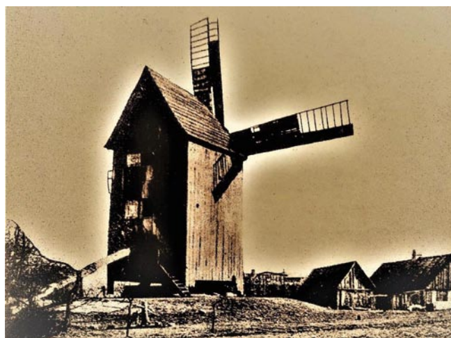
Rys. 4. Poznań zdjęcie rynku wildeckiego z 1890 roku. Wiatrak typu kozłak z widocznym charakterystycznym dyszlem. M. Warkoczewska „Dawny Poznań” Wydawnictwo Poznańskie, Poznań 1983
