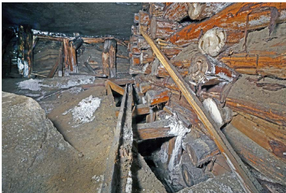
Ryc. 5. Fragment komory Kloski na poziomie V. Widoczne pozostałości danych ciągów solankowych. Stan na luty 2017. Komora jest obecnie zlikwidowana zaczynami uszczelniającymi. Fot. J. Przybyło.
