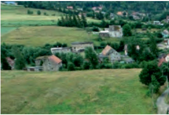
Rys. 1. Budynki mieszkalne objęte monitoringiem drgań parasejsmicznych Fig. 1. Residential buildings were subject to the monitoring of paraseismic vibrations
