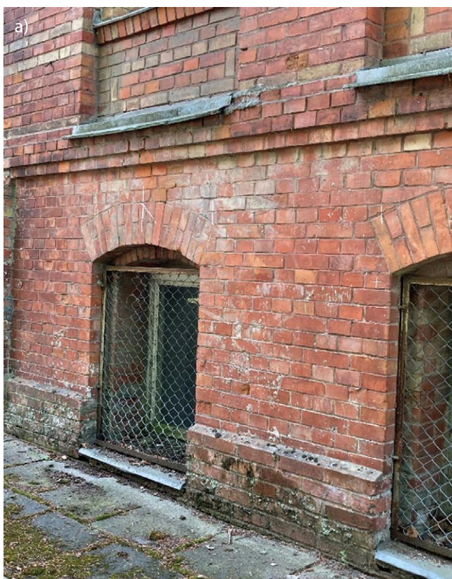
Rys. 1. Fotografie ocenianych ścian zewnętrznych budynków: a) stan dobry, b) stan zadawalający
