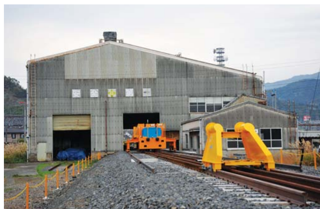
Stanowisko zmiany rozstawu kół na stacji Tsuruga, od strony torów o rozstawie 1067 mm. Fot. © JR West
