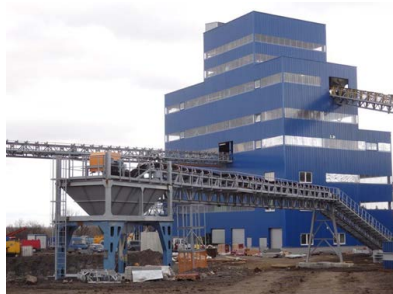
Foto. 3. Zakład przeróbki odpadów pogórnich Heřmanicka Hałda Ostrawa
