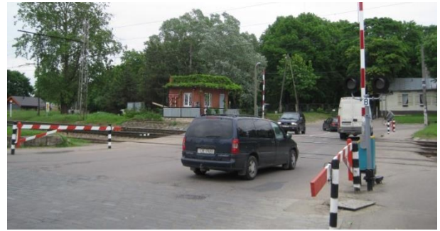
Rys. 5. Łotwa – przejazd obsługiwany przez dróżnika. Na fotografii przedstawiono zapasowe rogatki, zamykane ręcznie w przypadku awarii rogatek sterowanych elektrycznie [opracowanie własne]
