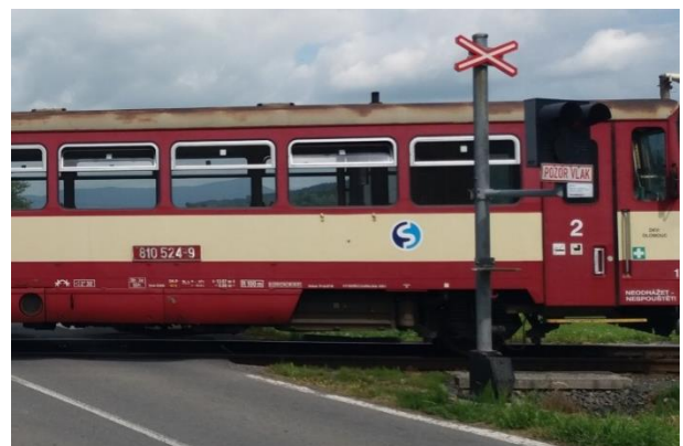
Rys. 8. Czechy – sygnalizator sygnalizacji przejazdowej uzupełniony o znak „uwaga pociąg” [opracowanie własne]
