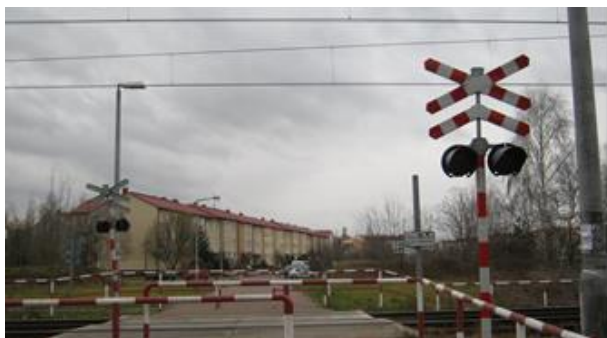
Rys. 11. Polska – przejście labiryntowe wyposażone w krzyż św. Andrzeja oraz sygnalizator drogowy [opracowanie własne]
