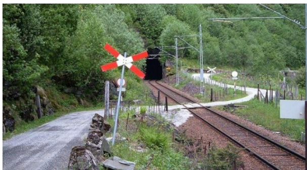
Rys. 10. Norwegia – krzyż św. Andrzeja w pewnym oddaleniu od przejazdu [1]
