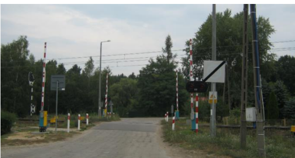
Rys. 4. Polska – przejazd kolejowy wyposażony w półrogatki zamykające całą szerokość jezdni i samoczynną sygnalizację świetlną [opracowanie własne]
