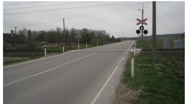
Rys. 6. Estonia – przejazd z sygnalizacją samoczynną wyposażoną w światło białe wolno migające, oznaczające poprawne działanie sygnalizacji [opracowanie własne]
