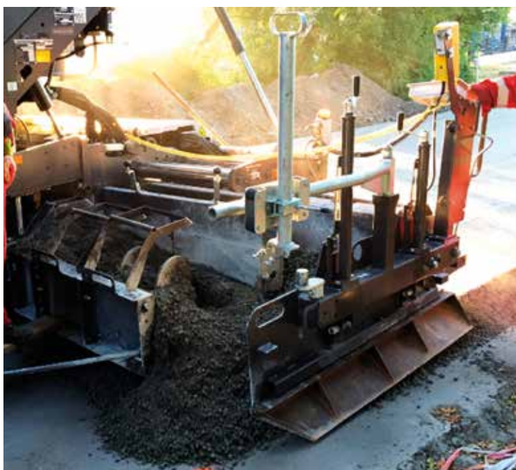
Rys. 2. Budowa nawierzchni z betonu wałowanego, ul. Makowska, Warszawa, czerwiec 2018 r. [1]
