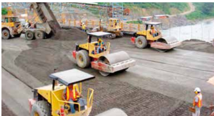
Rys. 1. Wykonywanie zapory wodnej w technologii betonu wałowanego [4]
