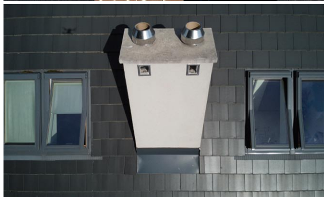
Rys. 1. Kominy dwuwarstwowe z wkładami stalowymi
