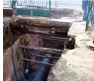
Fot. 2. Głębokość wykopu ok. 3 m, spowodowana występującymi kolizjami
