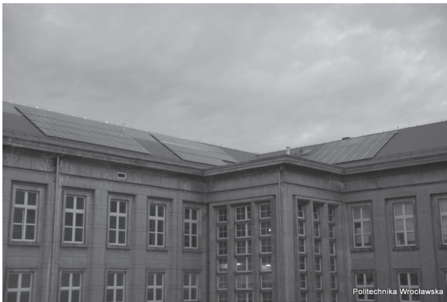
Rys. 1. System fotowoltaiczny na dachu budynku D-1 Politechniki Wrocławskiej
