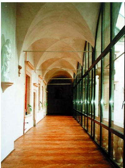
Nowa ściana osłonowa na piętrze, umożliwiająca pełną ekspozycję arkad. Fot. W. Klag
