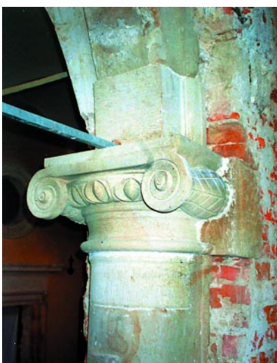
Głowice kolumn w trakcie odkrywania i prac konserwatorskich. Fot. W. Klag
