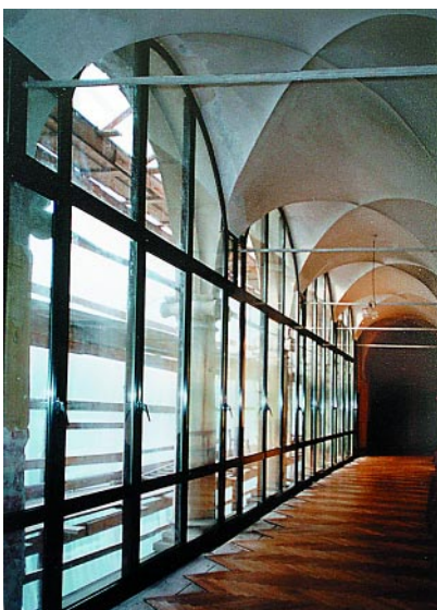
Ściana osłonowa galerii. Widok od wewnątrz w trakcie montażu. Fot. W. Klag
