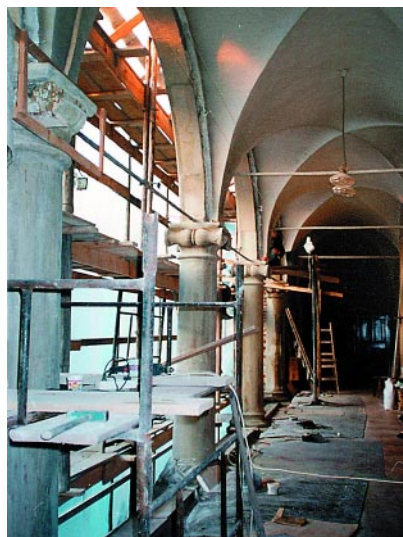
Odkrywanie arkad krużganka na piętrze. Lipiec 1995. Archiwum WUOZ w Krakowie
