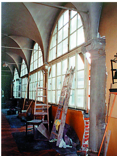
Demontaż obudowy krużganków na piętrze. Fot. W. Klag
