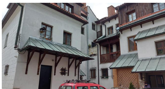
Rys. 5. Ocieplenie zewnętrzne budynku zabytkowego od strony oficyny (fot. M. Rogalska)
