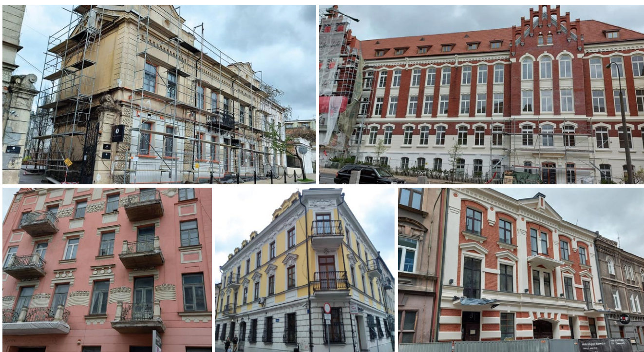
Rys. 3. Zabytkowe budynki w trakcie prac budowlanych w Lublinie fot. M. Rogalska
