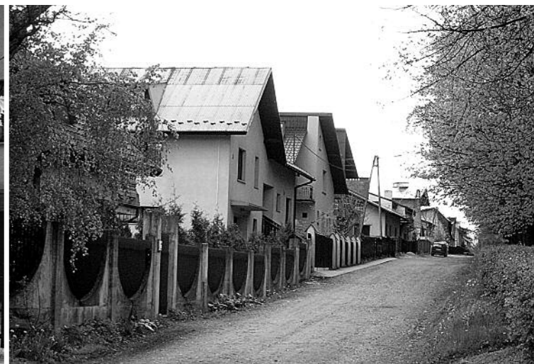
▼ Osiedle domów jednorodzinnych w N. Widok ulicy dojazdowej po stronie północnej zabudowy. Residential estate in N. View of access road on the North side.
