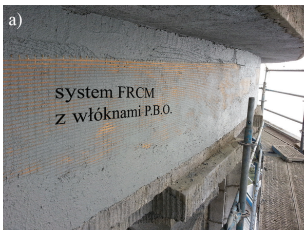
Fot. 3. Wzmocnienia pierścienia górnego kopuły północnej przy użyciu systemu FRCM: a) siatki z włókien P.B.O. po nałożeniu na matrycę mineralną, b) widok kopuły po renowacji (fot. M. Jackiewicz)
