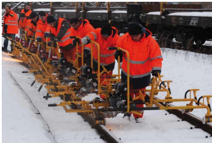
Rys. 1. Szlifowanie szyn szlifierkami ręcznymi (Źródło: Vossloh)
