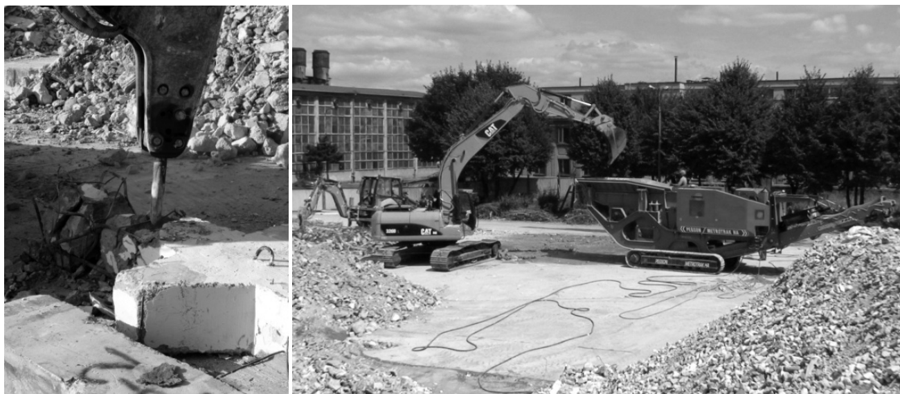
Rys. 1. Wstępne kruszenie słupów prefabrykowanych użytych w badaniu
