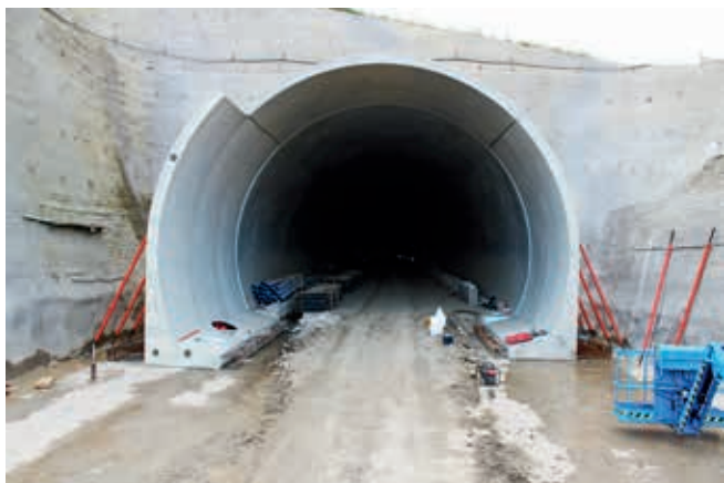
Trzecia część montażu prefabrykatów w części północnej portalu zachodniego
