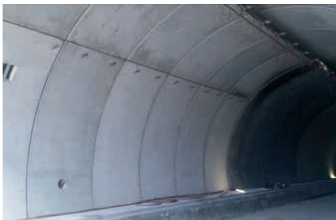
Wnętrze tunelu – szczegół połączenia prefabrykowanych segmentów
