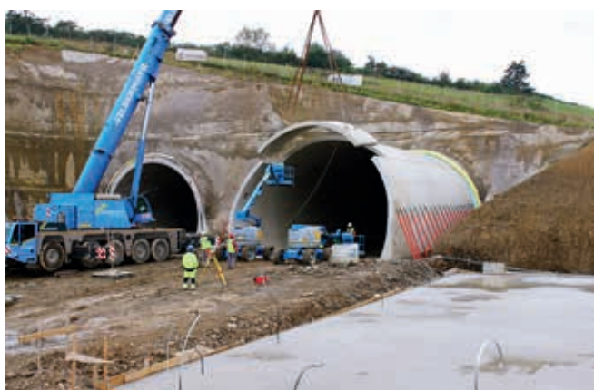
Montaż prefabrykowanych elementów tunelu Šibenik
