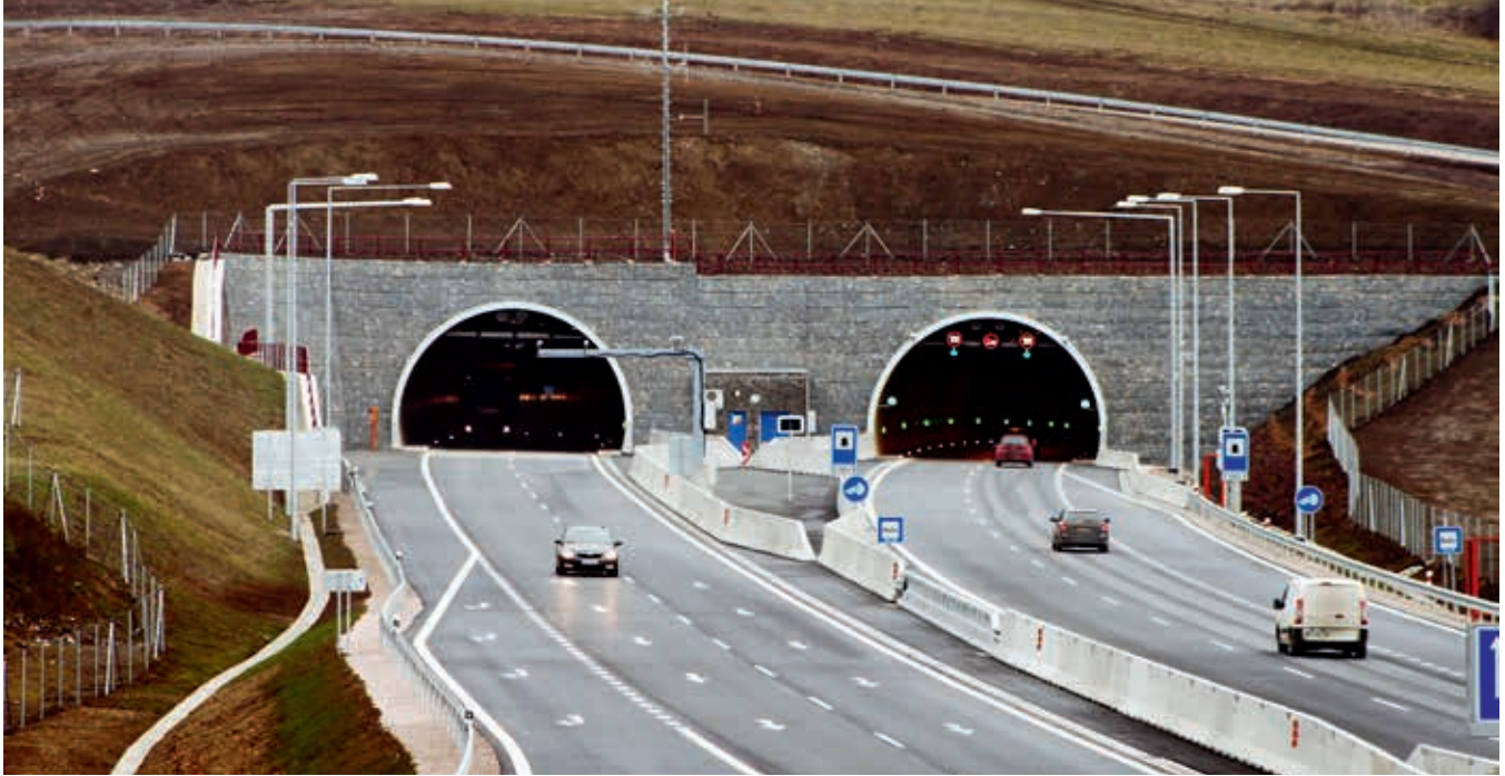
Tunel Šibenik, część zachodnia, grudzień 2015 r.
