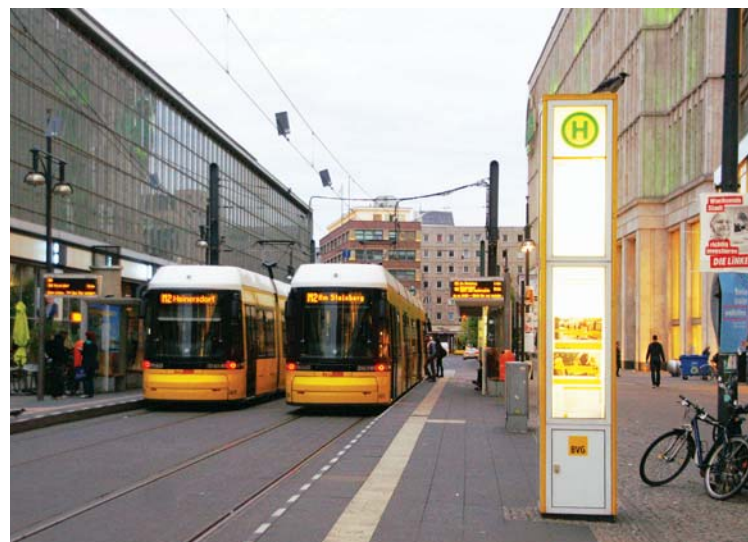
Przystanek końcowy linii tramwajowej M2 w bezpośrednim sąsiedztwie stacji metra i kolei miejskiej S+U Alexandrplatz. Fot. Z. Rusak
