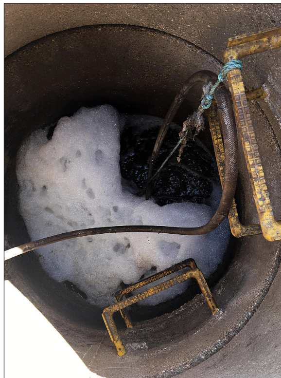
Rys. 3. Studnia z dyfuzorem Fig. 3. Well diffuser aeration
