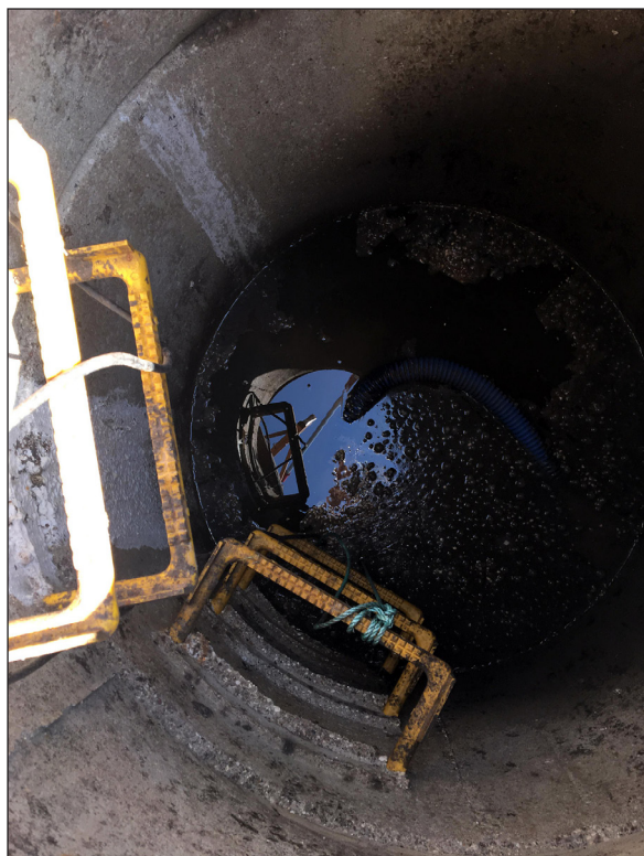
Rys. 2. Osadnik gnilny Fig. 2. Septic tank
