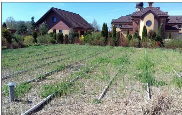
Rys. 5. Złoże gruntowo-roślinne w okresie wiosennym i letnim Fig. 5. Filter with soil and plant in spring and summer
