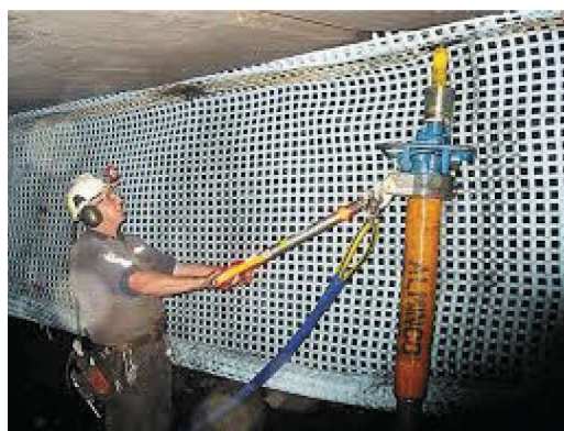
Rys. 9. Wykonywanie obudowy kotwowej w kanale likwidacyjnym z zastosowaniem kotwiarki ręcznej (www.dsiunderground.com)
