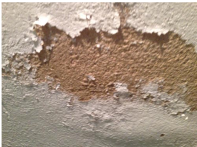
Rys. 3. Odpadający tynk na skutek działania grzybów
