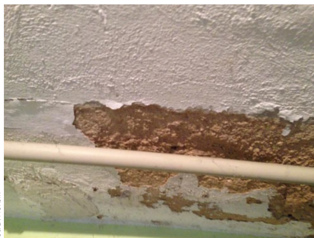
Rys. 4. Spękania ściany spowodowane rozwojem grzybów
