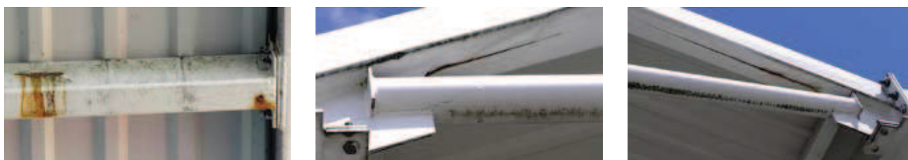
Rys. 5. Przykłady utraty ciągłości materiału stalowego na szwach spawalniczych
