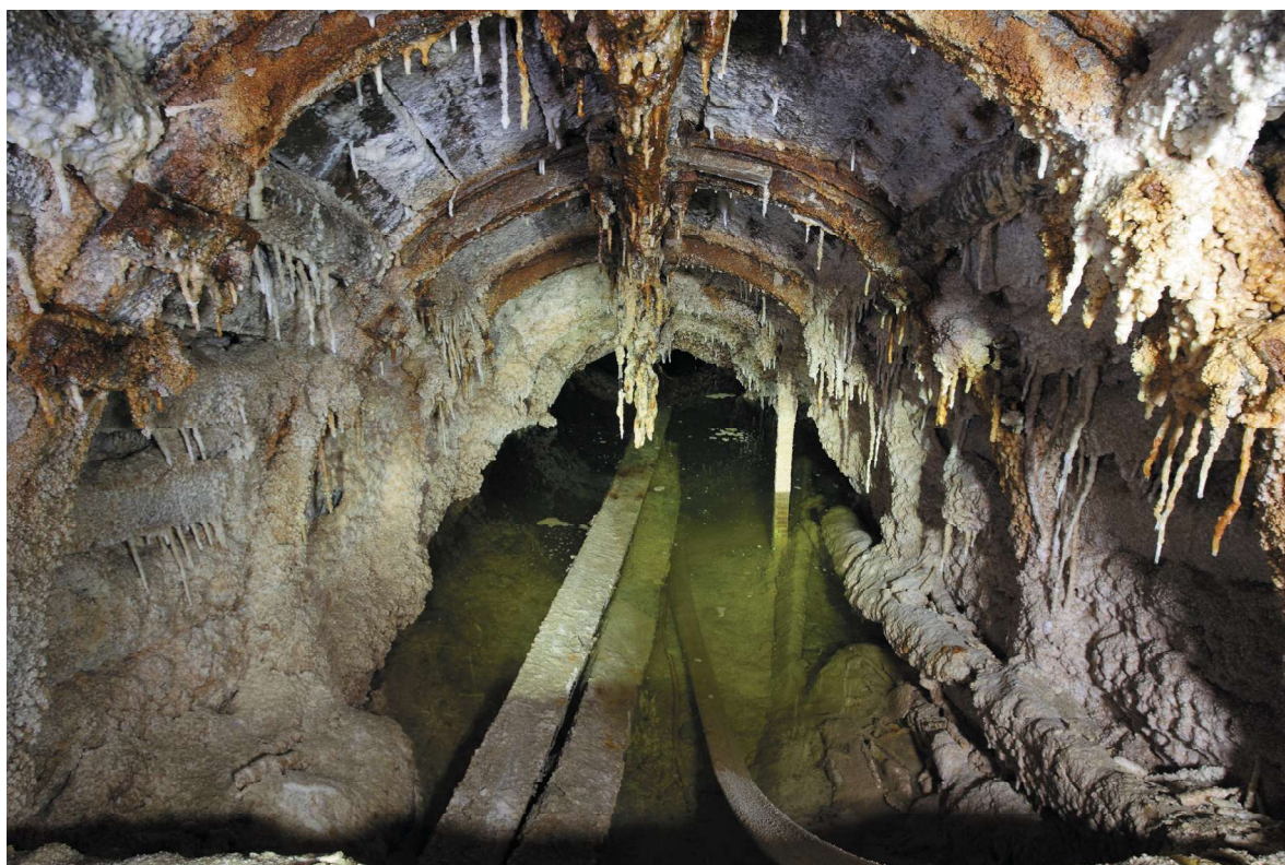
Rys. 4. Pochylnia Centralna z poz. VIII na poz. IX zalana w 1992 r. awaryjnymi wodami z pop. Mina w 1992 r. (fot. J. Przybyło)
