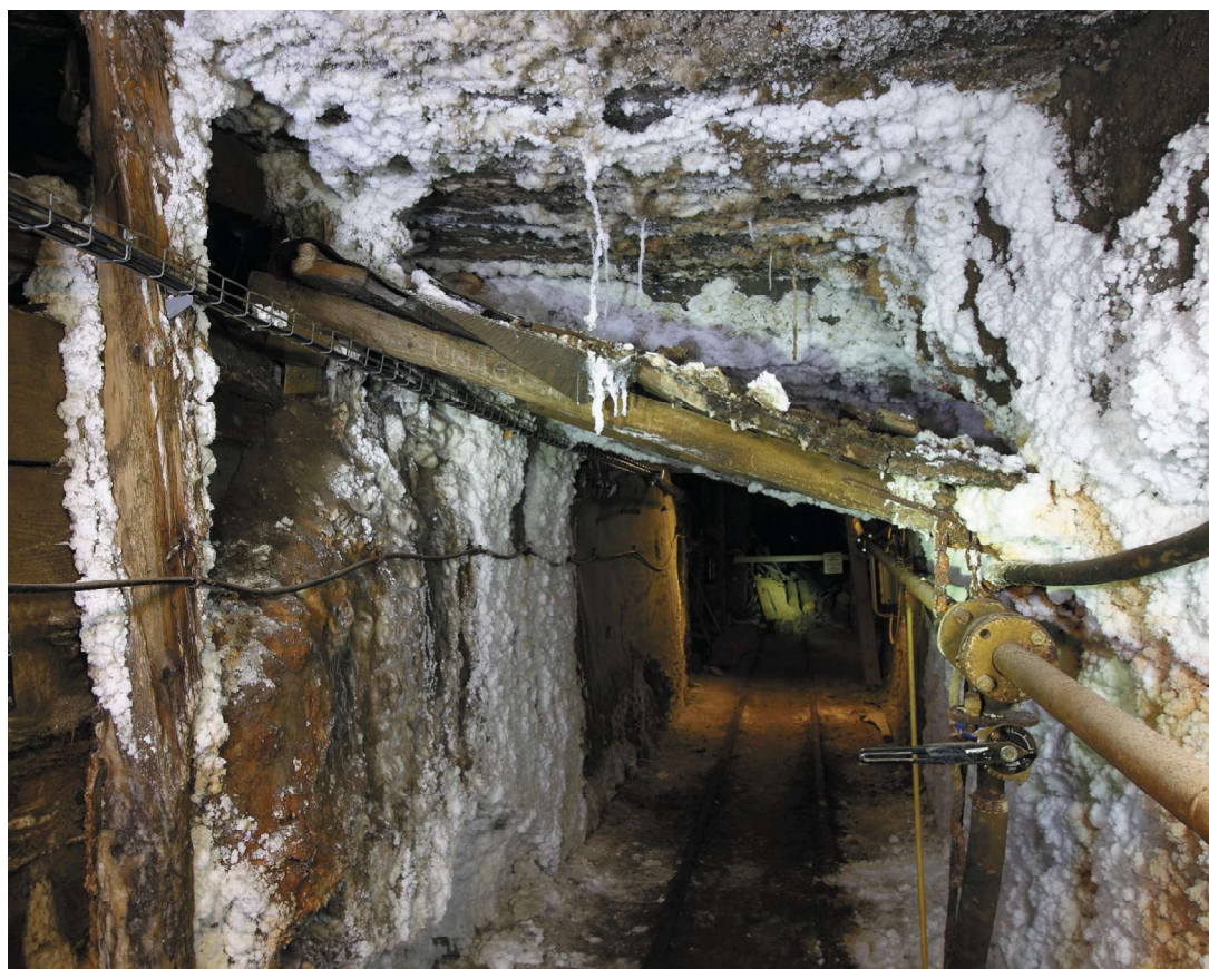
Rys. 1. Wypływ solanki w poprzeczni Kaniów w kopalni Wieliczka (fot. J.Przybyło)
