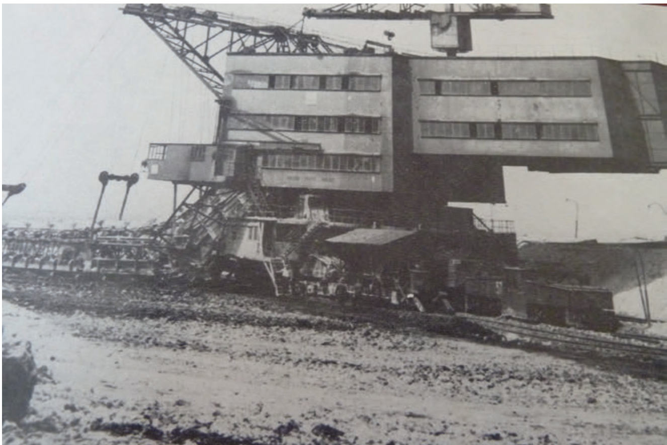
Kopalnia Turów - Koparka łańcuchowa Ds 1120 z szynową odstawą urobku w odkrywcę Turów 1
