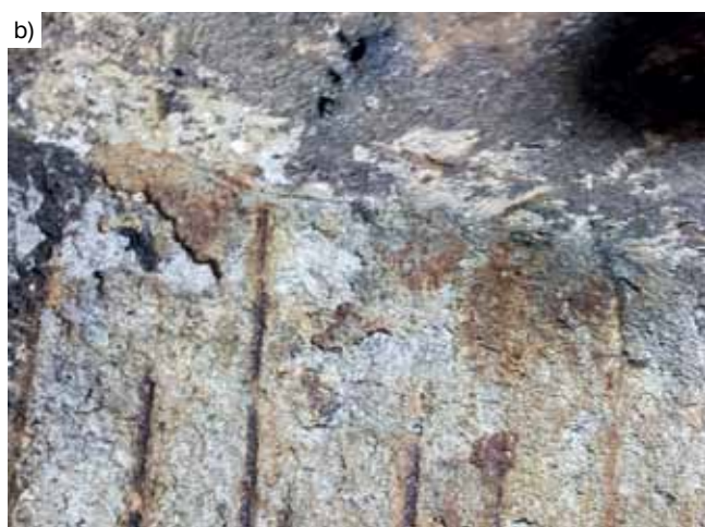
Rys. 3. Destrukcja komory rozdzielczej ścieków (obiekt nr 3) po około 10 latach użytkowania: a) wejście do komory – korozja betonu z odsłoniętym zbrojeniem, b) powierzchnia betonu pokryta produktami korozji, c) destrukcja ściany i widocznymi głębokimi wżerami w betonie w dolnej części i skorodowanym zbrojeniem
