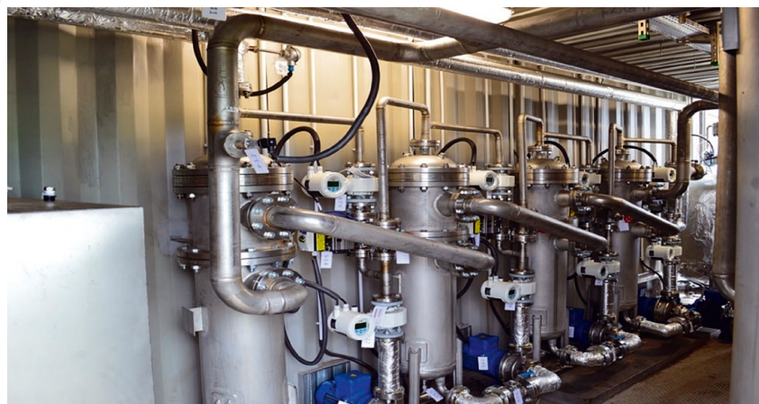
Fot. 2. Kontenerowa instalacja do oczyszczania biogazu z reaktorami SFR o wydajności 200 m 3 /h (zdjęcie autora)
