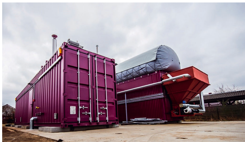
Fot. 1. Biogazownia kontenerowa o mocy 10 kW (zdjęcie autora)
