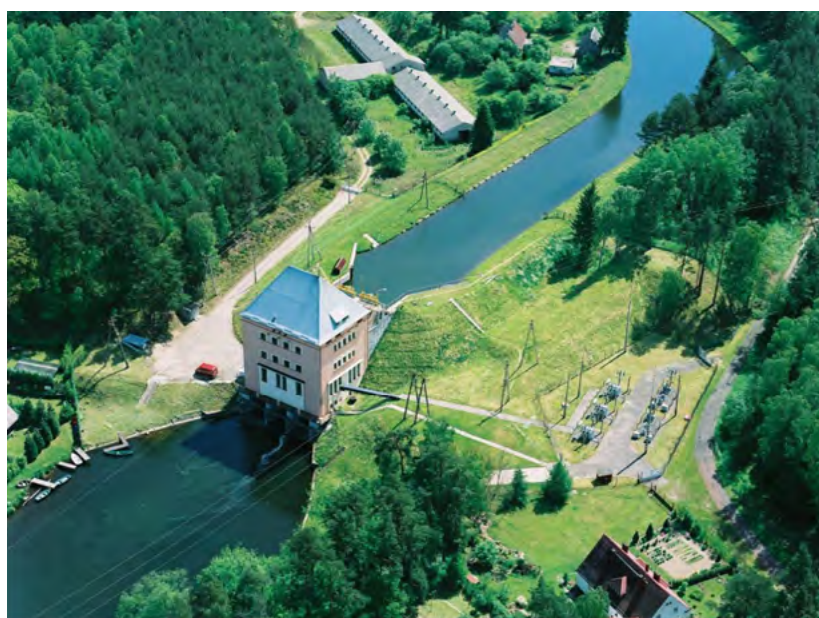
Zdj. 1. Elektrownia Rosnowo. Widok sprzed modernizacji. Po prawej stronie widoczne stanowisko transformatorów blokowych i potrzeb własnych z układami kompensacji sieci
