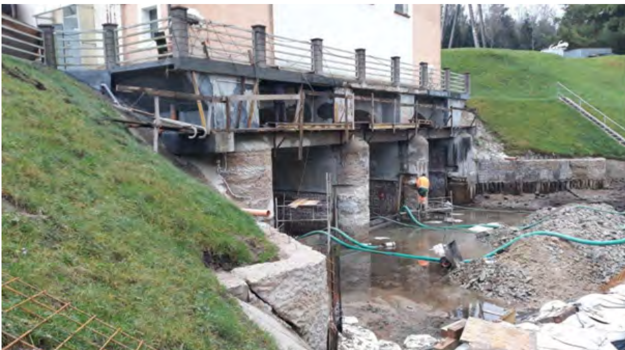
Zdj. 6. Elektrownia Rosnowo. Widok przed modernizacją. Wyloty z turbin w trakcie prac hydrotechnicznych
