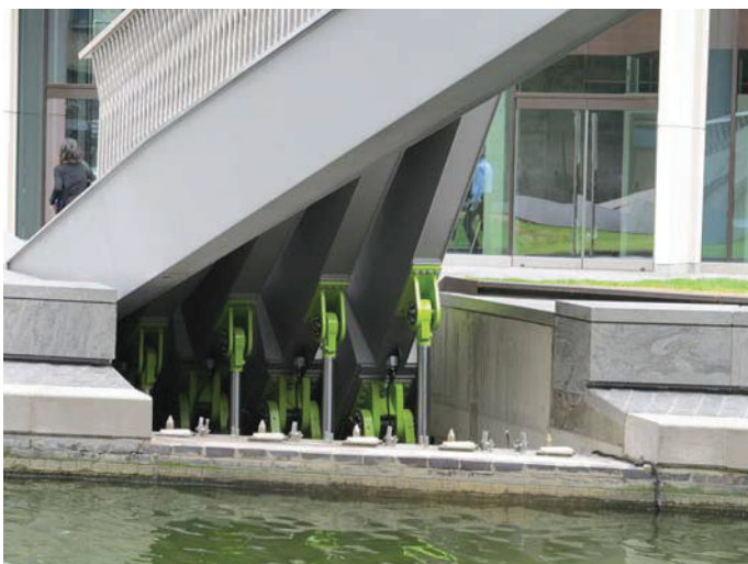
Fot. 15. Układ podnośników uruchamiających mechanizmy
