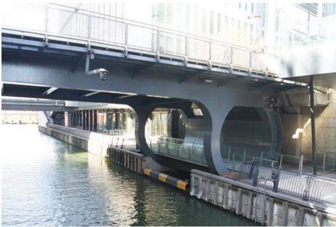
Fot.10. Niedoszły transporter bridge zamieniony na kładkę z windami
