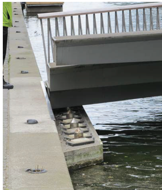
Fot. 14. Domykanie kładki-wachlarza z osadzeniem na przeciwnym brzegu
