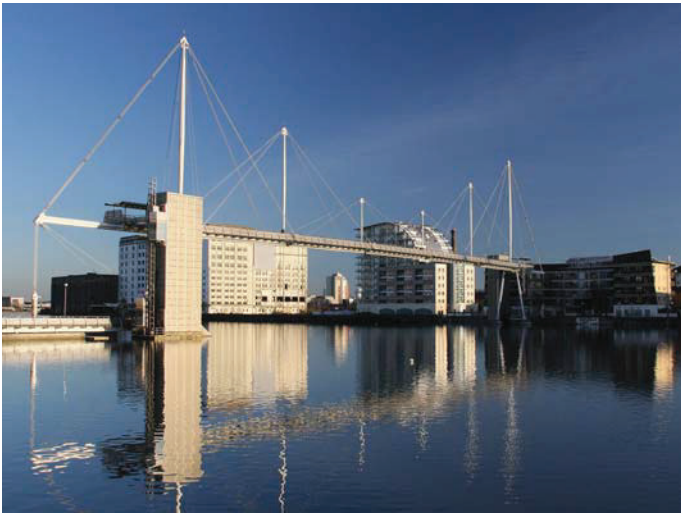
Fot.10. Niedoszły transporter bridge zamieniony na kładkę z windami
