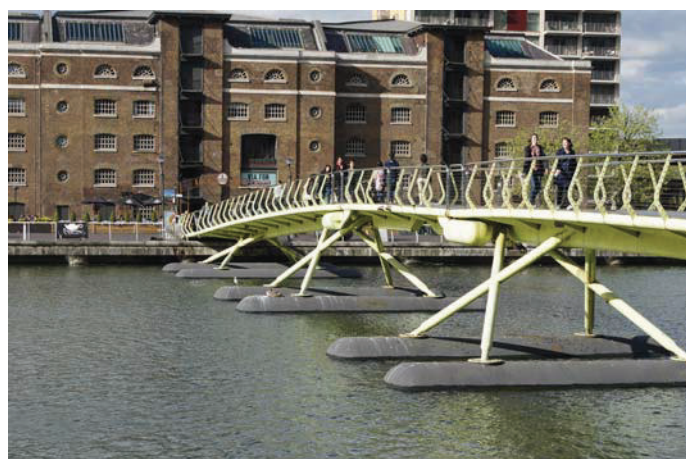
Fot. 9. Kładka na pływających podporach
