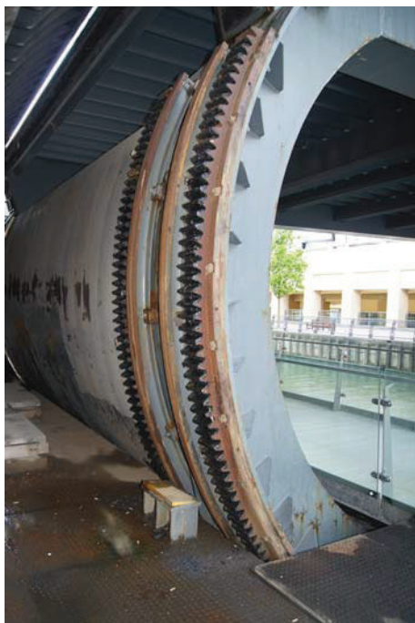
Fot. 11. Kładka z przęstem obracającym w płaszczyźnie pionowej i jej mechanizm
