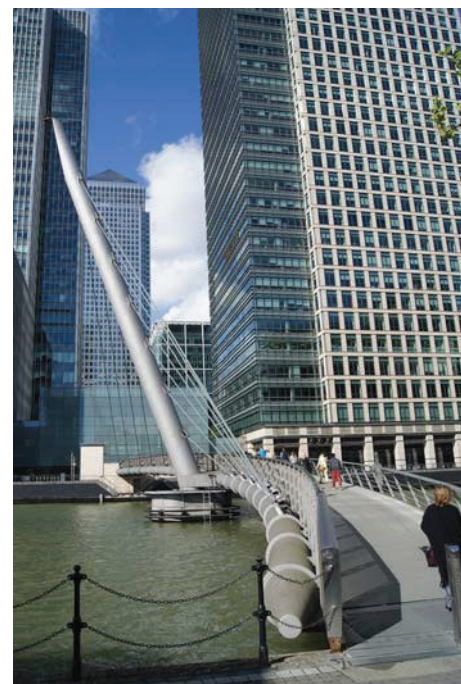
Fot. 5. Kładka w Paddington – jednostronnie podwieszona na skośnym pylonie, z pomostem zakrzywionym w planie
