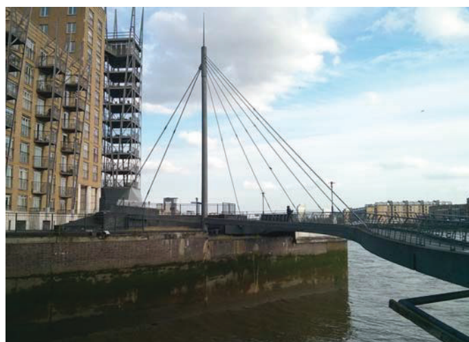
Fot. 7. Ruchoma kładka podwieszona obracana w płaszczyźnie poziomej
