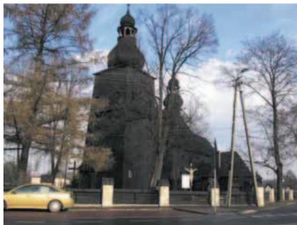
Fot. 1. Widok budynku kościoła od strony południowo-zachodniej Photo 1. View of the church from the south-west
