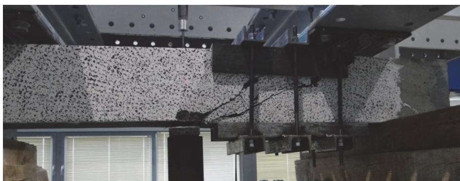
Rys. 6.61. Ogólny widok belki ze stalowym wzmocnieniem przejmującym siły ścinające w zniszczonej strefie przypodporowej, po I etapie badania (opis w tekście) (Głodkowska i Lehmann 2016/2017)
