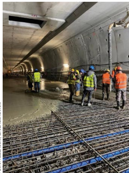
Rys. 12. Betonowanie zbrojenia pod jezdnię w tunelu
