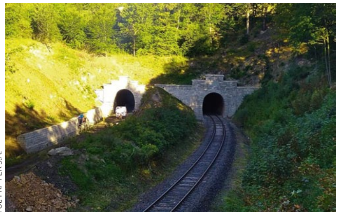
Rys. 6. Tunel kolejowy pod Małym Wołowcem
