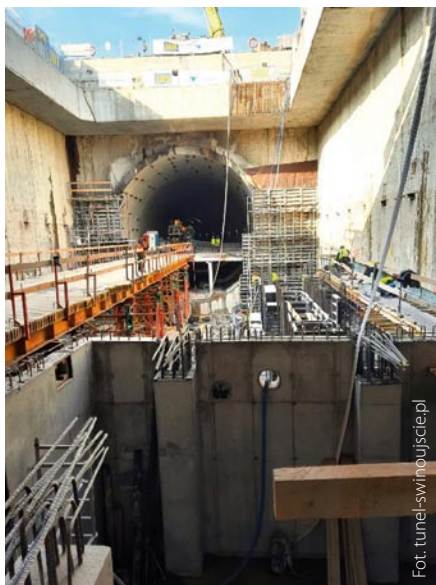
Rys. 8. Plac budowy podwodnego tunelu pod Świną – komora odbiorcza
