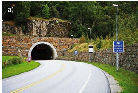
Rys. 2. Tunel Lærdal w Norwegii: a) wjazd do tunelu od strony południowo-zachodniej (źródło: xdmag, Licencja: CC-BY-SA), b) oświetlenie niebiesko-żółte w wykutej w skale jaskini (źródło: Svein-Magne Tunli)
