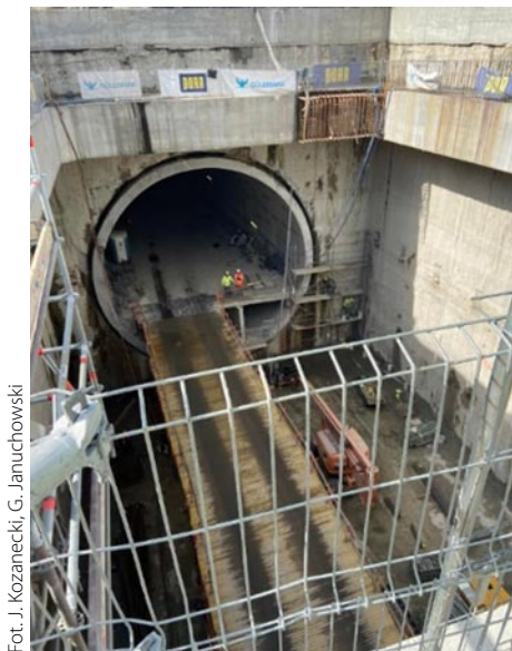
Rys. 12. Betonowanie zbrojenia pod jezdnię w tunelu
