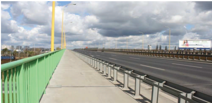
Rys.5. Widoczne trzy pasy ruchu, szeroki chodnik zabezpieczony balustradą i barierą. Całkowita szerokość estakady 15,4 m, widoczny chodnik o szerokości 3,0 m
