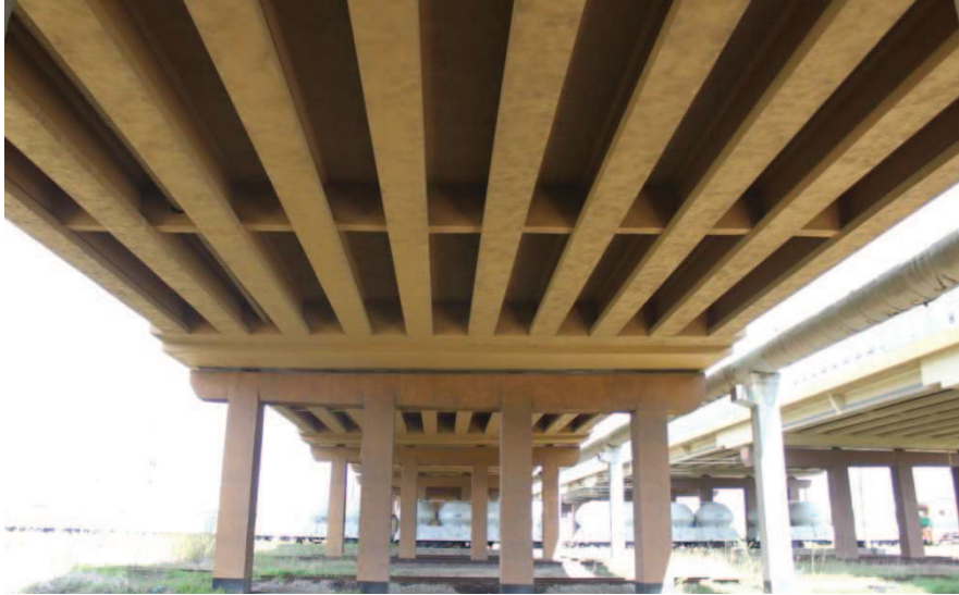
Rys. 4. Dziesięć belek pomostowych spiętych poprzecznkami podporowymi i przeszłowymi zmodernizowanej estakady Wiaduktu Franowo
