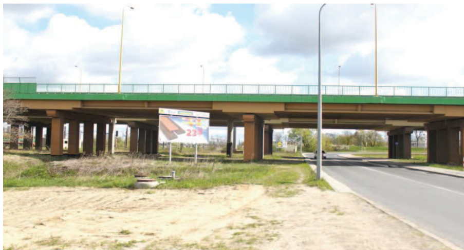
Rys. 3. Wiadukt Franowo przebiega również nad drogą kołową. Obecny widok estakady zachodniej (zielone gzymsy)
