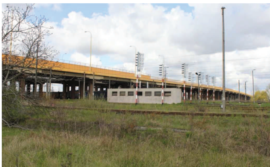
Rys.1. Wiadukt Franowo od strony wschodniej (pomarańczowe gzymsy)
