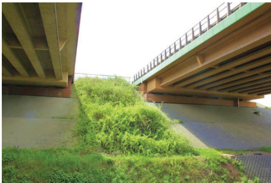
Rys.2. Wiadukt Franowo składa się z dwóch estakad: wschodniej i zachodniej
